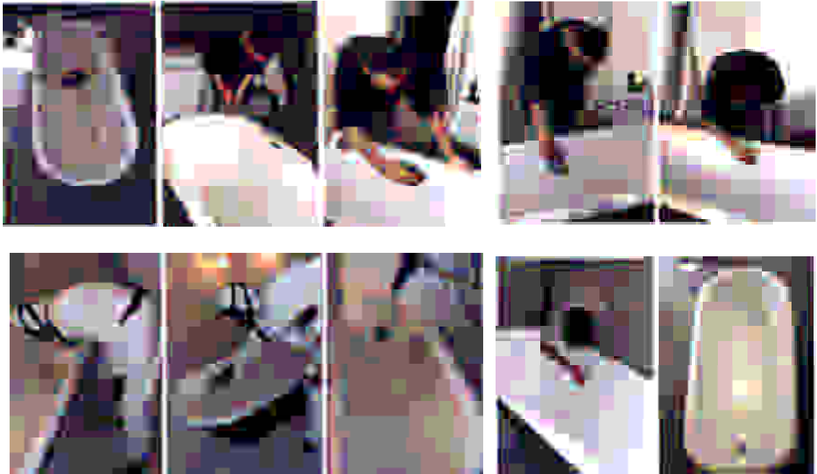
Abb. 2: Arbeitsschritte Remaill-Beschichtungsverfahren
