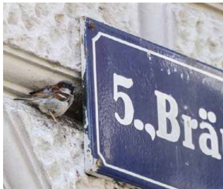
5. Bezirk, Bräuhausgasse: Der Hohlraum zwischen Straßenschild und Fassade wird von den Haussperlingen als Nistplatz genutzt.
