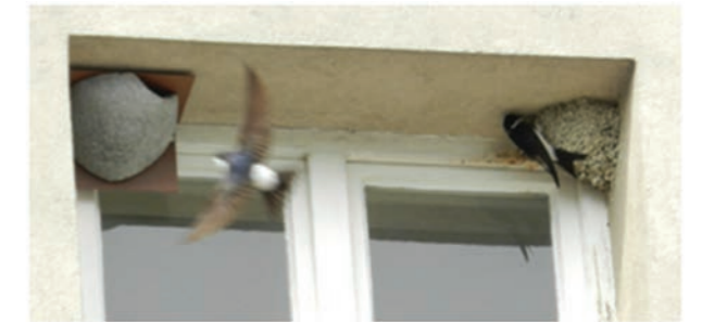
22. Bezirk, Goethehof: Vorbereitung auf eine Fassadensanierung: Erstes Kennenlernen von Kunstnestern. Foto: M. Stocker
