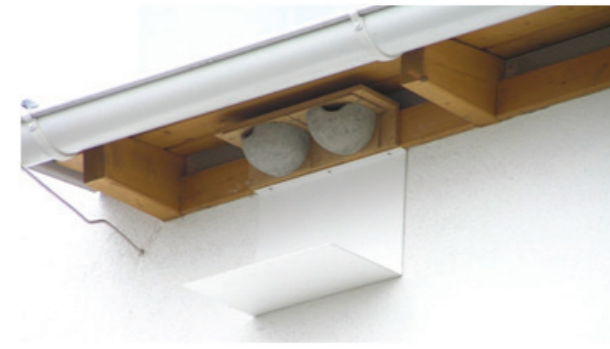
Linz, Solarcity, Mehlschwalben: Zwei Kunstnester unter der Dachkante mit montiertem Kotbrett. Foto: M. Stocker
