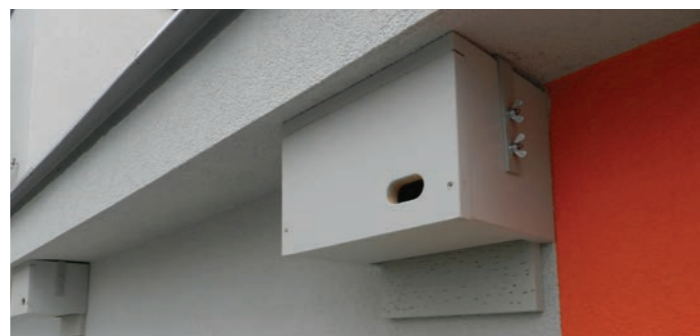
5. Bezirk, Einsiedlergasse: Unter dem Dachüberstand verschraubte Mauerseglernistkästen mit rückseitig integriertem Fledermausquartier (Eigenbau). Foto: M. Stocker
