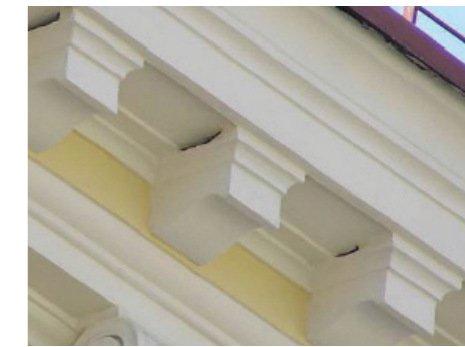
4. Bezirk, Argentinierstraße: Schmale Einflugöffnungen reichen dem Mauersegler, um in den meist hohlen Innenraum der Zierkonsole zu gelangen. Foto: M. Stocker
