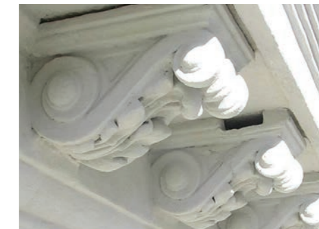
5. Bezirk, Kriehberggasse: Für Mauersegler geöffnete Zierkonsole. Foto: M. Stocker
