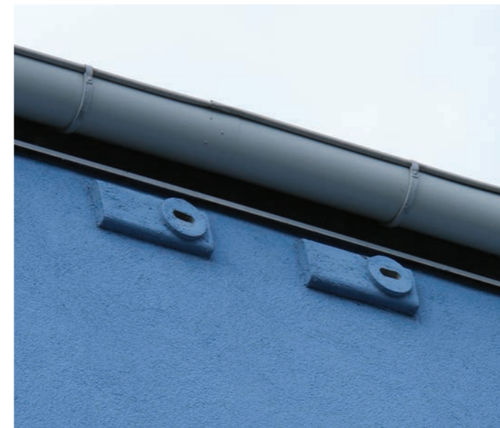
22. Bezirk, Hirschstetnerstraße: Mauerseglernistkästen, die im Zuge einer thermischen Sanierung in die wärmedämmte Fassade eingelassen wurden. Foto: M. Pendl
