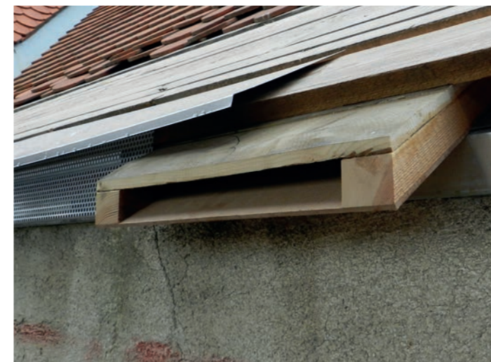
10. Bezirk, Triesterstraße: Das Spaltenquartiers im Zwischendach ist nach fertiger Montage kaum zu sehen, das Insektenschutzgitter wird zugunsten der Fledermäuse unterbrochen. Foto: M. Stocker
