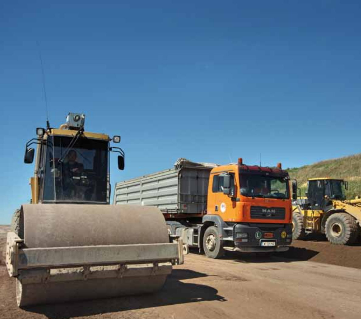
Einbau von stabilisierten Verbrennungsrückständen auf der Deponie Rautenweg
