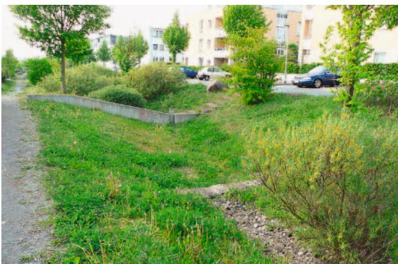
Regenwasserversickerung über Mulden/Rigolen (Abb.: www.wikipedia.org ; freie Lizenz)
