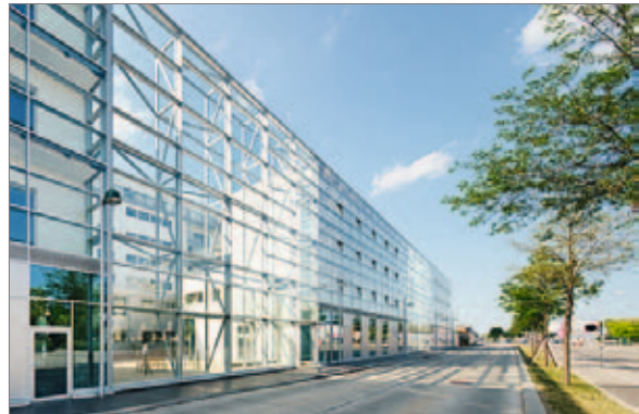
Lärmschutzfassade (Abb.: Sne Veselinovic/Rupert Steiner)
