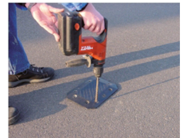
Abb. 12: Montage der Plattenmessgeräte (Foto: Global Traffic Service GmbH)
