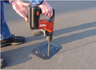
Abb. 2: Montage der Plattenmessgeräte (Foto: Global Traffic Service GmbH)
