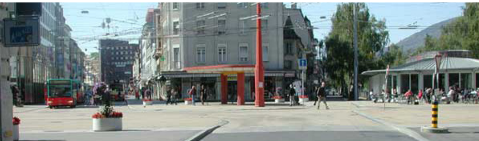
Abb. 6 Bahnhofsvorplatz in Biel, gestaltet nach dem Prinzip der „Begegnungszone“
