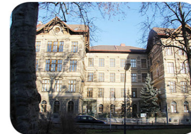
Lycee Francais ▣ Grinzinger Straße 95 Schulbau mit Straßenhof wurde 1895 erbaut
