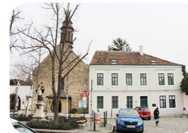
Ehem. Schule ▣ Pfarrplatz 4 Kern Anfang 16. Jahrhundert, diente als Volksschule, als Mesnerhaus. Fassade aus dem dritten Viertel des 19. Jahrhunderts
