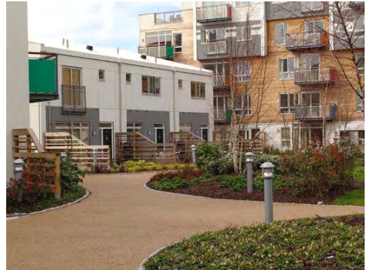
Unterschiedliche Gebäudehöhen innerhalb eines Blockes, Greenwich Village, London
