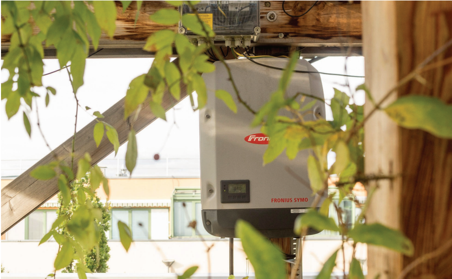
Abb. 21: Wechselrichter im PV-Dachgarten BOKU-IBLB (Markus Weidmann-Krieger, 2022)
