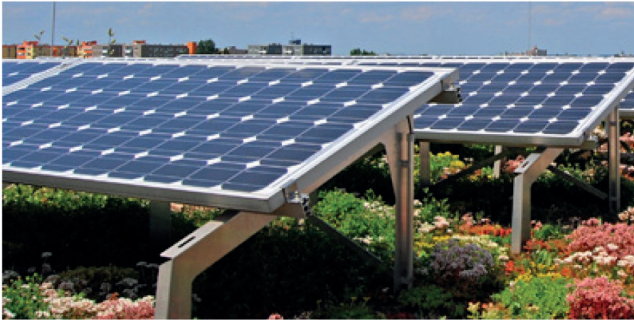
Abb. 16: PV-Gründach mit aufgeständerten PV-Modulen und extensiver Vegetation (Zinco, o.J.)
