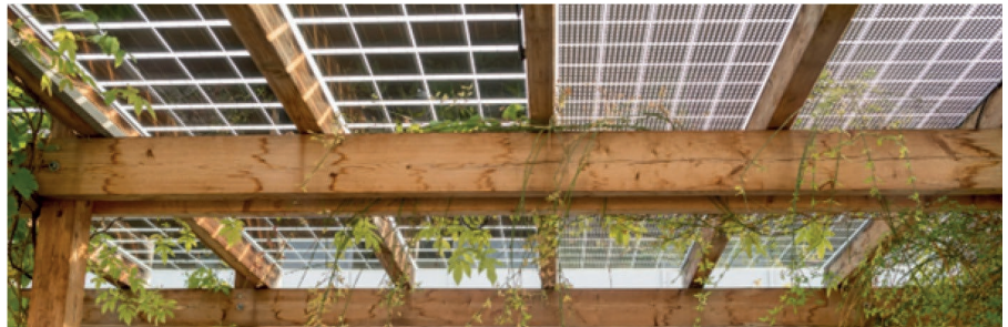
Abb. 15: PV-Pergola BOKU, IBLB: Zwei Modultypen mit unterschiedlichen Lichtdurchlässigkeiten kommen hier zum Einsatz (Weidmann-Krieger, 2022)
