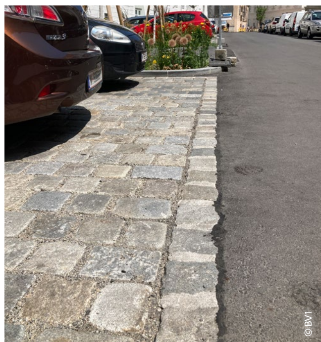
Der Wiener Würfel lässt mehr Wasser versickern
