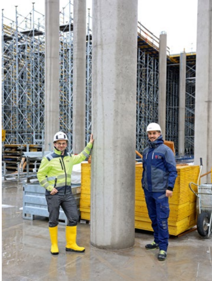
Projektleiter Tobias Gauster (l.) und Betonprüfer Stefan Söllner
