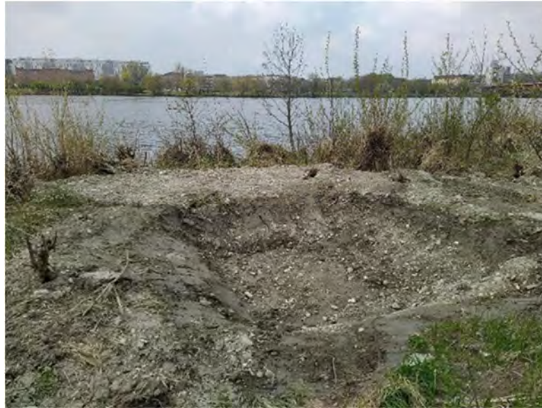
Abbildung 15: Grabungsarbeiten für die Ping-Pong Teiche unterhalb des DICCA Teichs
