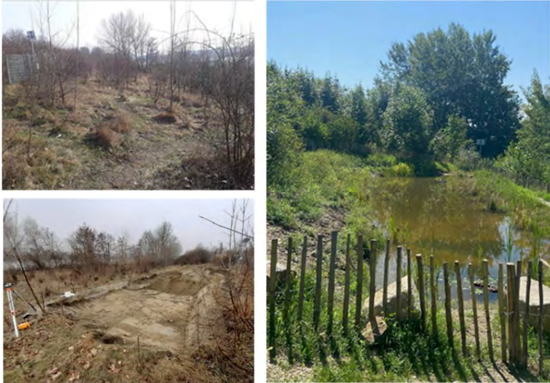
Abbildung 12: Links oben: vor dem Teichbau, links unten: Grabungsarbeiten DICCA Teich; Rechts: Fertiger DICCA Teich
