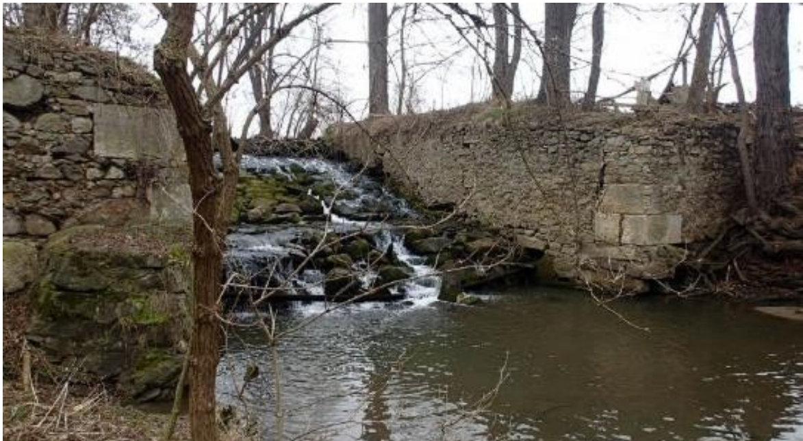
Abbildung 24 Nicht fischpassierbares Querbauwerk an der Pulkau
