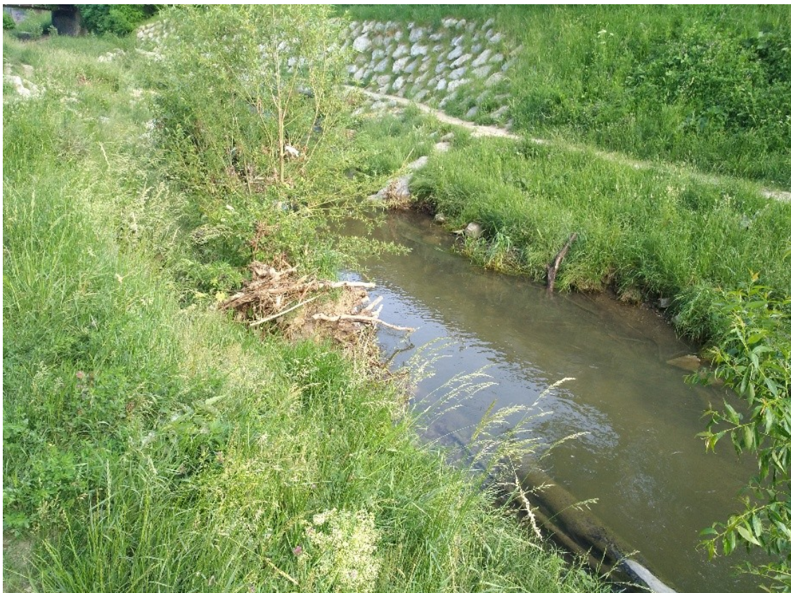
Abbildung 20 Foto Liesing flussab Mündung Dürre Liesing – Tiefstellen und direkte Beschattung durch Totholz, Ufergehölze 2 Jahre nach Bau noch relativ klein
