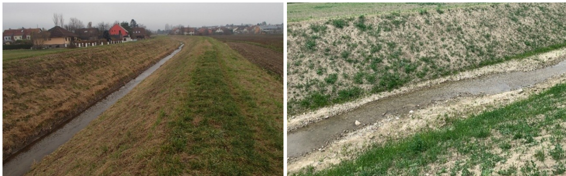
Abbildung 10 Hagenbach– gepflasterte Sohle vor Umbau 2016 (links). Hagenbach natürliche Gewässersohle 2025 nach ökol. Begleitplanung im Zuge HWS-Ausbau (rechts)
