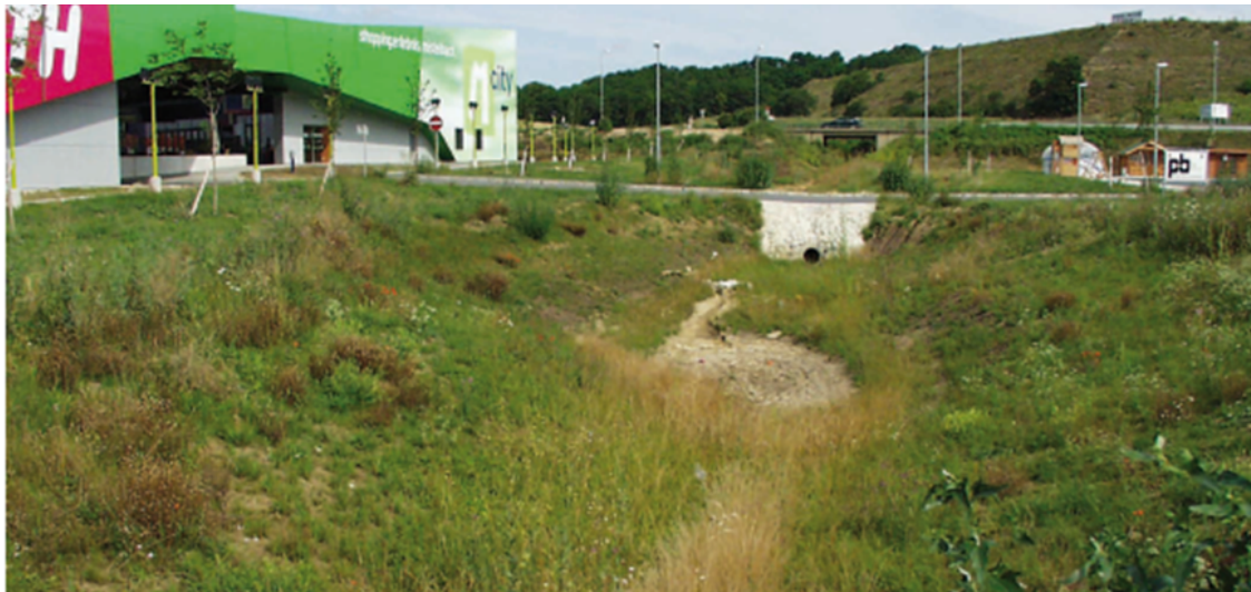
Abbildung 45 Extensiv gepflegte Retentionsmulde in Mistelbach
