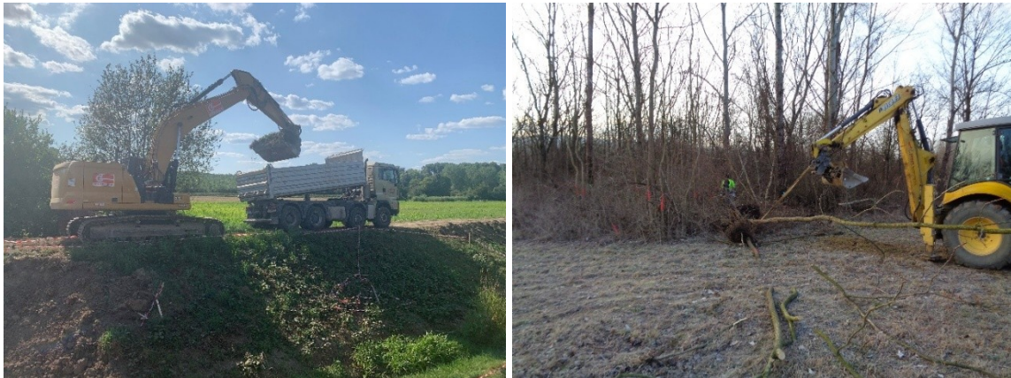
Abbildung 39 Abtrag Staudenknöterich aus Böschung und fachgerechte Entsorgung (links). Entfernung Götterbaum im Rahmen Errichtung FWH Greifenstein (rechts)
