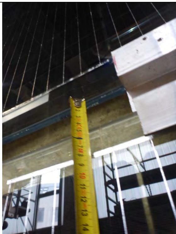
Abbildung 9-30: PV-Module Abstand übereinander
