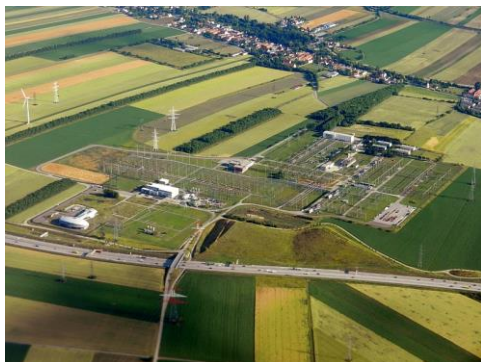
Abbildung 85: Umspannwerk Wien Südost
