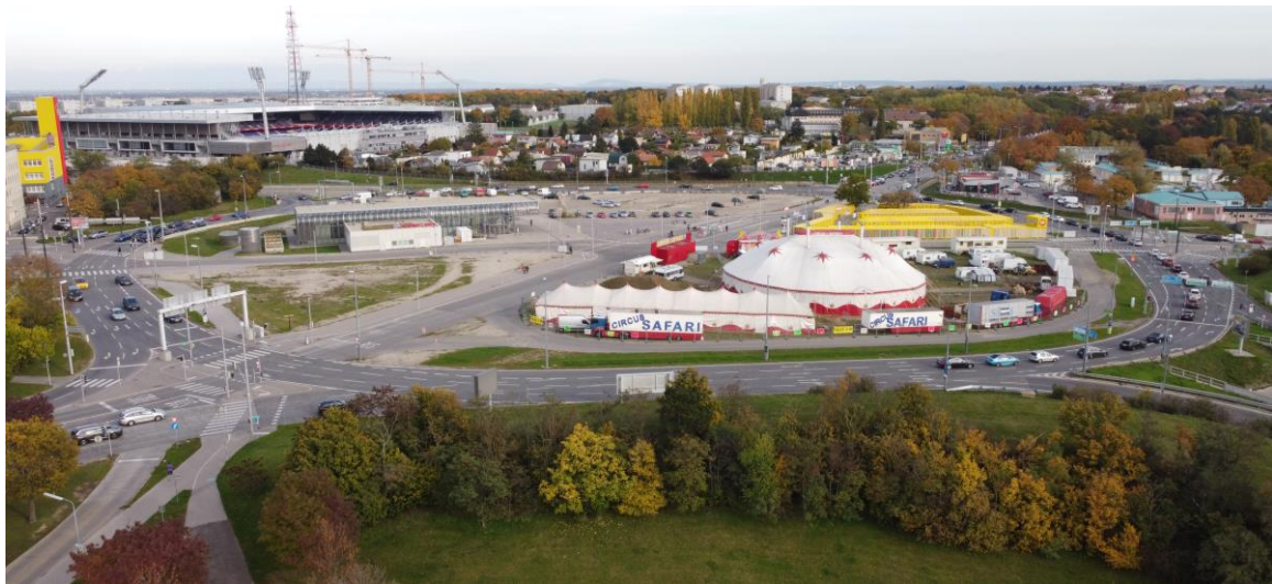
Abbildung 35: Verteilerkreis Favoriten mit Generali-Arena im Hintergrund (Quelle: Knollconsult)
