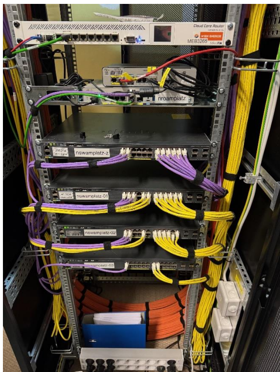
Abbildung 5: Kabelführung der Patchkabeln im Schrank bei 24/48-Port Switches
