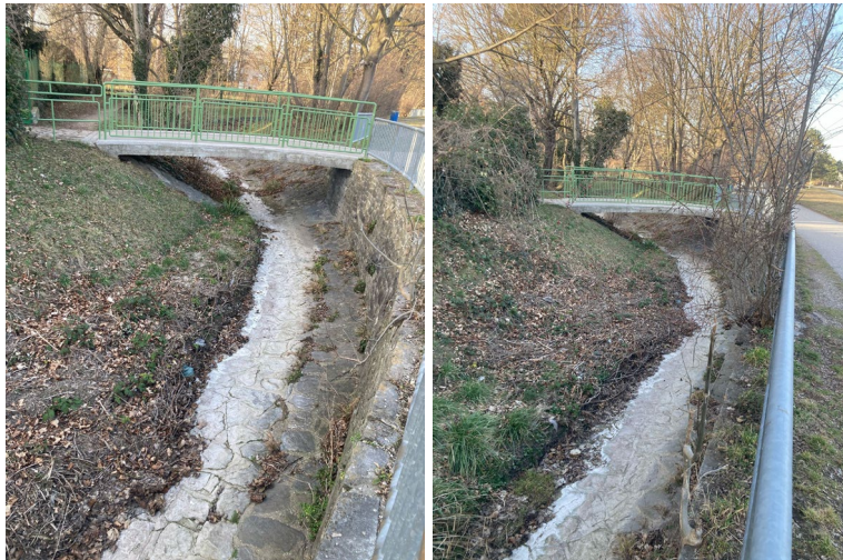
Darstellung des um ca. 50% verengten Bachlaufes auf Höhe der Fußgängerbrücke Schillerpromenade Blickrichtung Endstation 60er Straßenbahn in Rodaun.
