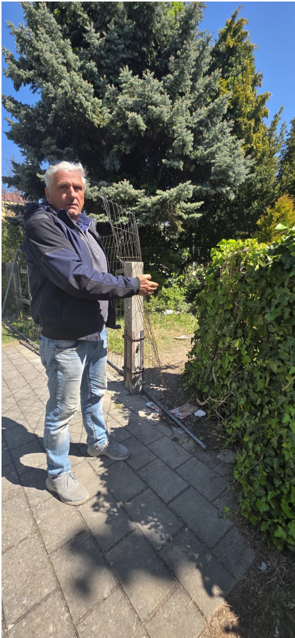
Der Bauzaun ist nur angelehnt, und die Baustahlgittermatte stellt eher eine Gefährdung als eine Absicherung dar.
