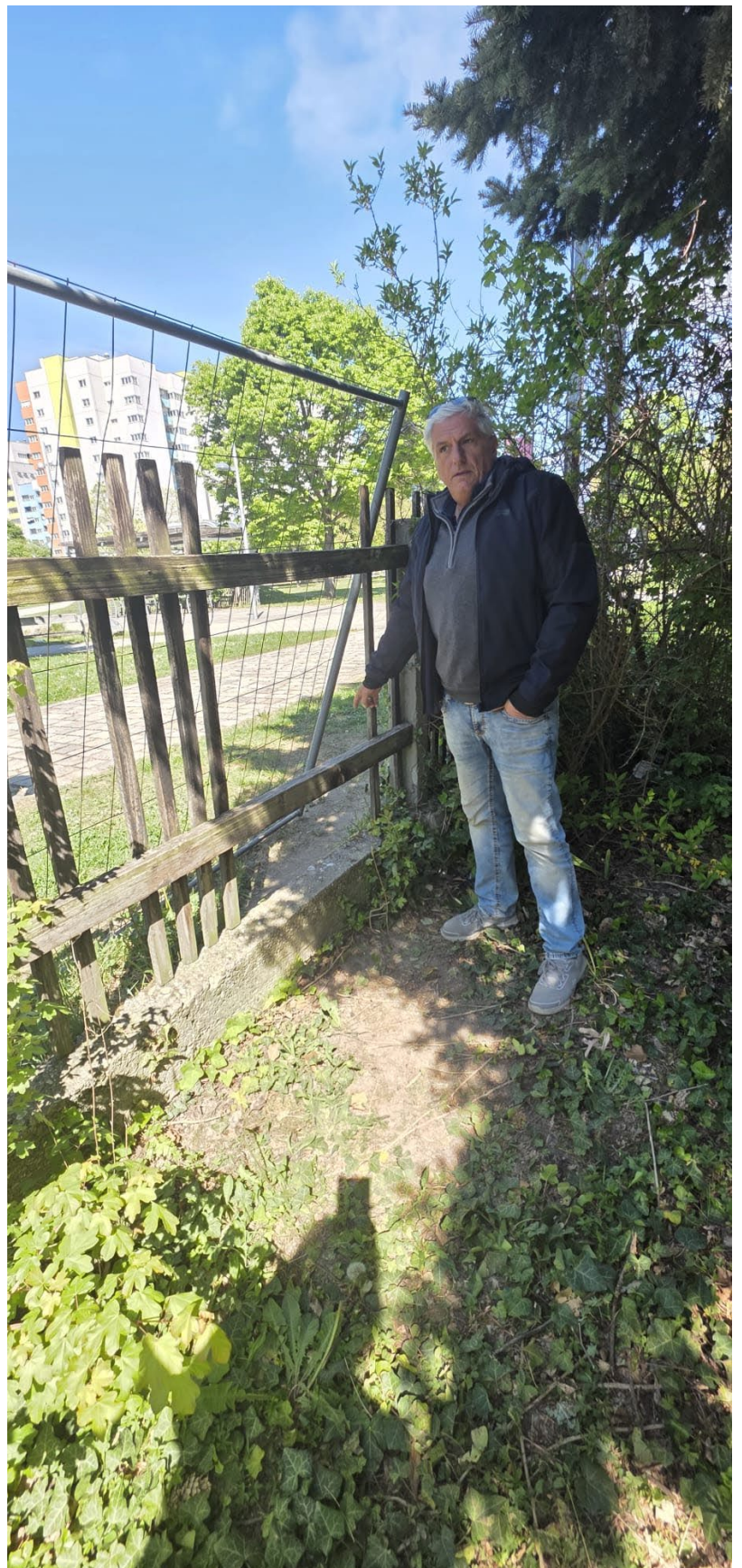
Der Bauzaun ist nur angelehnt, und die Baustahlgittermatte stellt eher eine Gefährdung als eine Absicherung dar.
