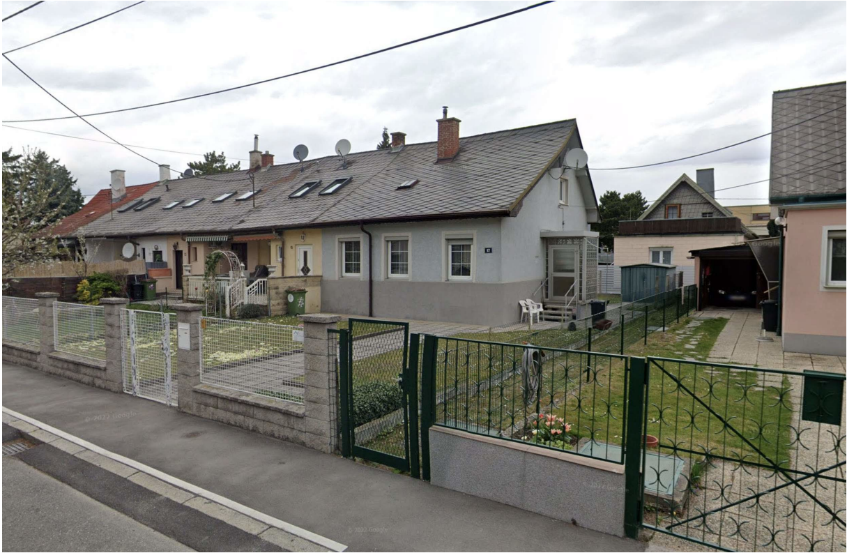
Haus Schwemmäckergasse 17 vor dem Abriss
