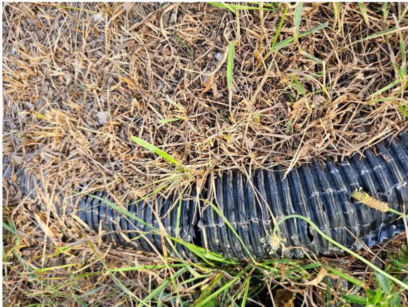
Bild 2: beschädigter Bewässerungsring
