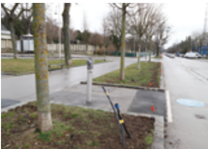
In der Alszeile wird für die Bäume ein automatisches Bewässerungssystem installiert.
