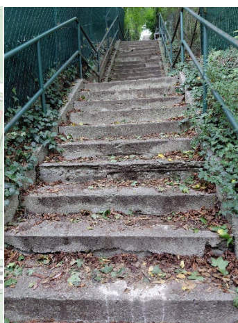
Desolate Treppe, Bewehrungsstahl sichtbar
