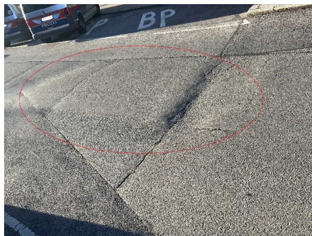
Abbildung 2:Detailansicht Fahrbahnschäden Albert Schweitzer Gasse
