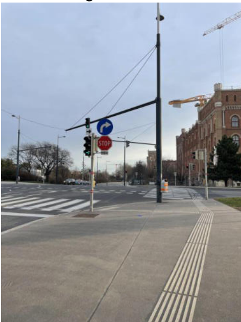
Bild: Ampelanlage Arsenalstraße
