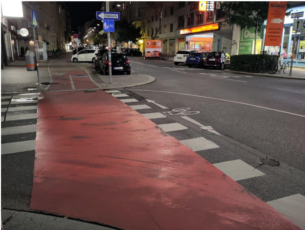
Abbildung 3: Vorbild für Piktogramm aus Sicht der einbiegenden Fahrzeuge zum Hinweis auf den Zweirichtungsradweg: Kreuzung Margaretenstrasse / Paulanergasse
