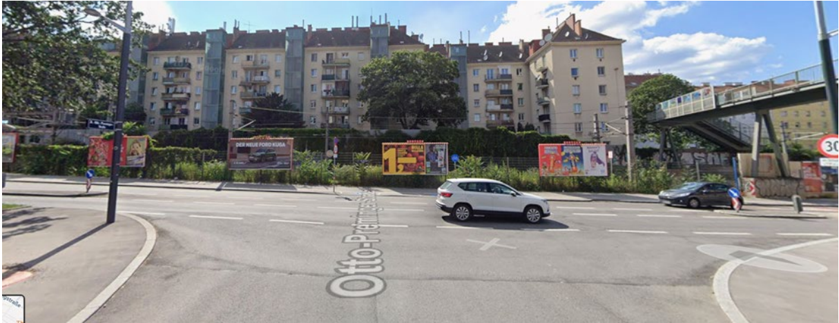
Blick von der Otto-Preminger-Straße aus; abgeschrägte Gehsteige am Radweg bereits vorhanden
