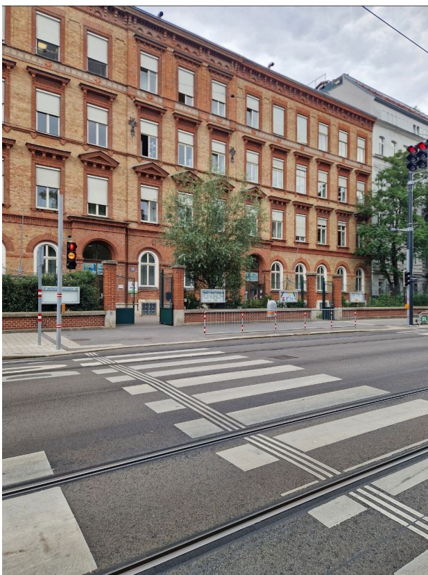
Bild: Fahrbahnsituation vor der Volksschule Vorgartenstraße 191
