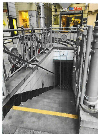
WC-Anlage Am Hof
