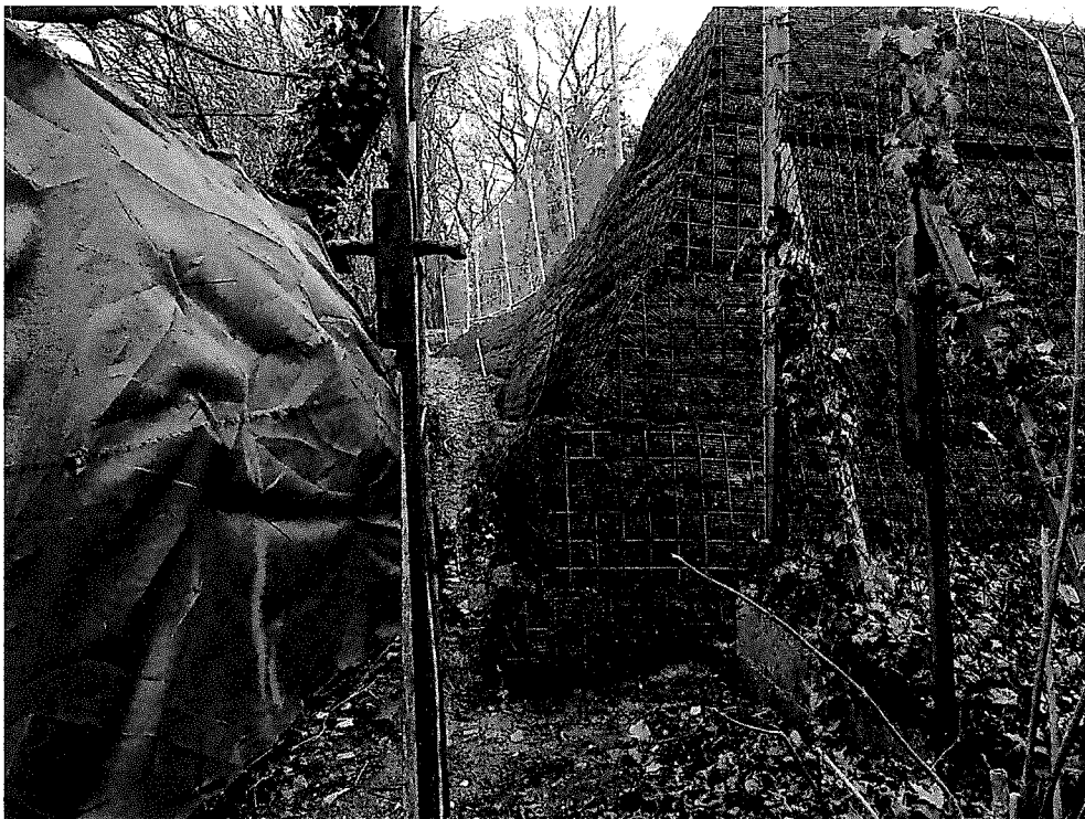
Neue Stützmauer direkt auf dem "Mauserlweg"
