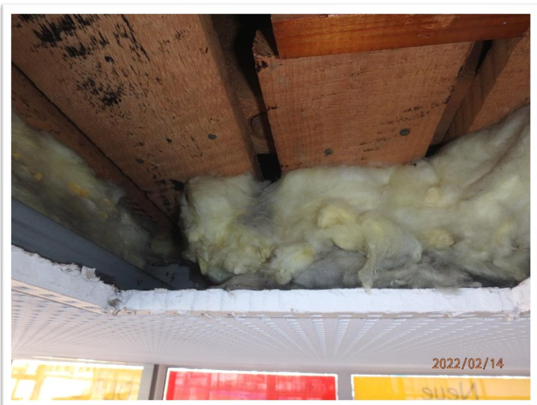
Bild 13: Dämmauflage abgehängte Decke (Quelle aetas ZT GmbH)
