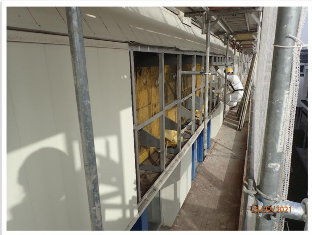
Bild 12: Wärmedämmung Fassade mit Glaswolle (Quelle aetas ZT GmbH)
