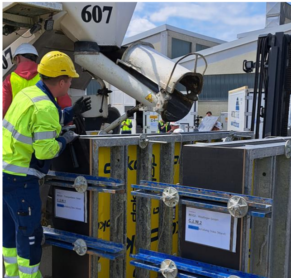
Abb. 18: Einfüllen Beton in Wandschalung
