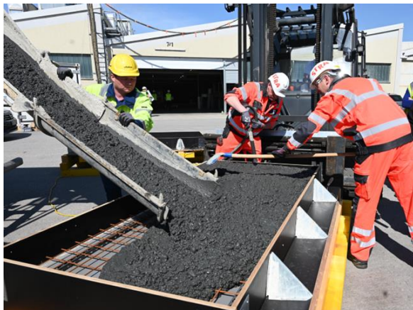
Abb. 12: Schritt 1 = Einfüllen des RCC2+-Betons in Deckenschalung
