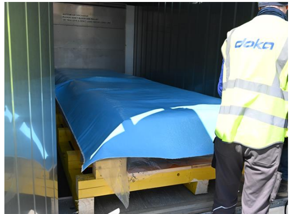
Abb. 17: Schritt 6 = Auflegen Winterschutzmatte
