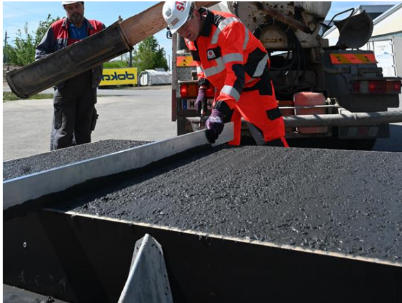
Abb. 14: Schritt 3 = Abziehen der Decke RCC2
