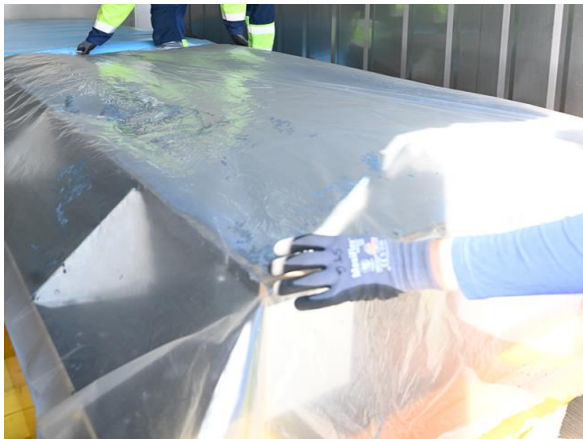
Abb. 16: Schritt 5 = Auflegen PP-Folie
