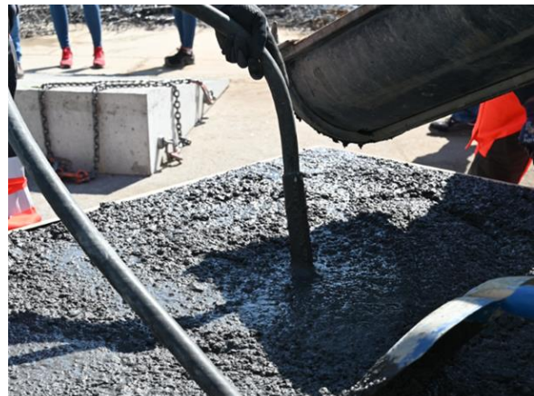
Abb. 13: Schritt 2 = Verdichten des RCC2+-Betons mittels Rüttler
