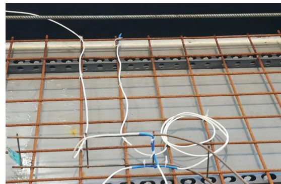
Abb. 9: Messstellen Concremote an Decke
