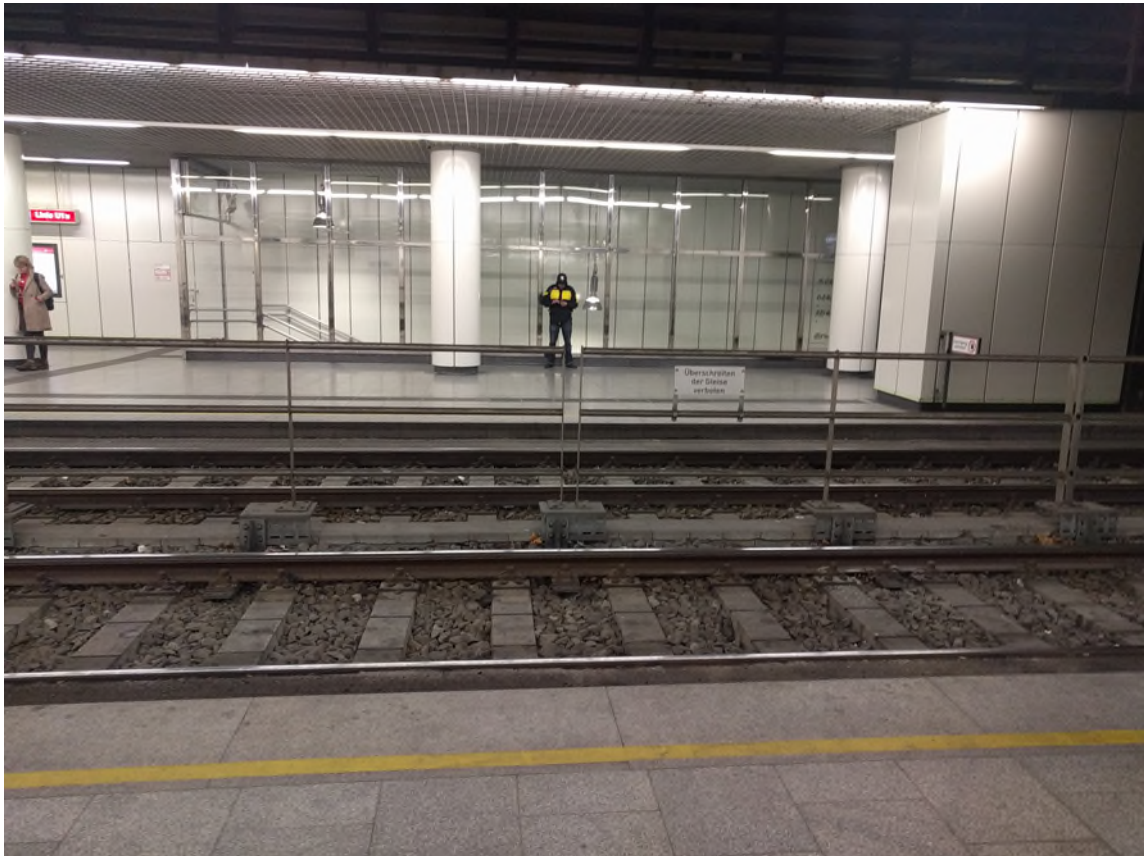
Illustration 2: UstraB Station Hauptbahnhof mit Absperrung
