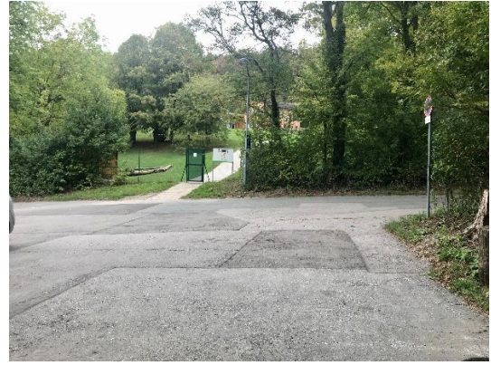
Foto 2: Teil des Parkplatzbereiches vor Kindergarten
