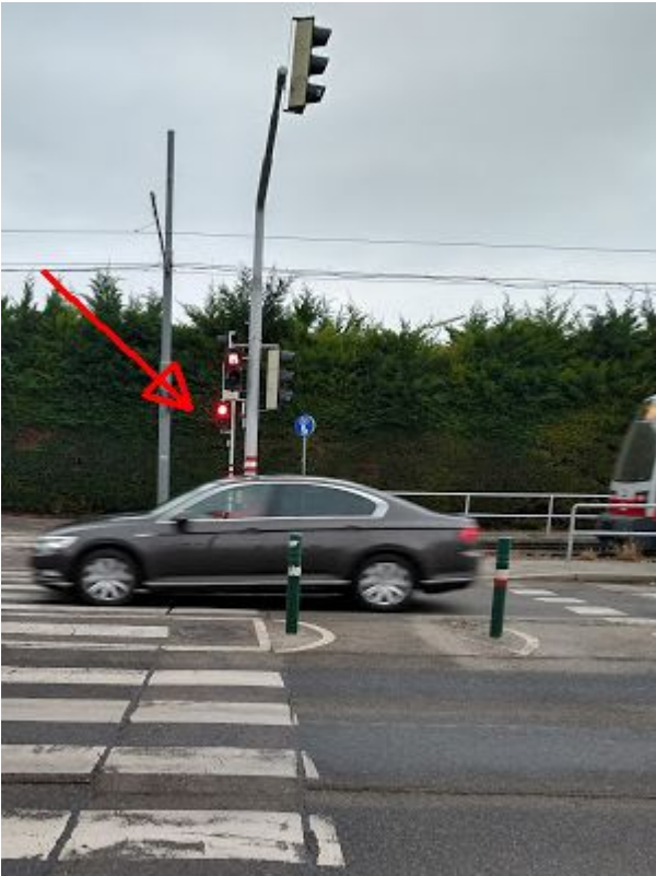
Abb. 1 Gleisampel bei herannahendem Zug auf rot umgestellt
