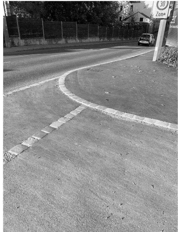
Diese Gestaltung führt bei Linksabbiegen zu einem Kurvenradius für PKW, bei dem sogar die Gegenspur einbezogen werden muss.
