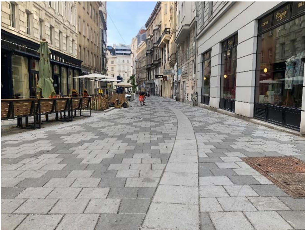
Abbildung 57 Niveauausgleich und Pflasterung, Begegnungszone Zollergasse
