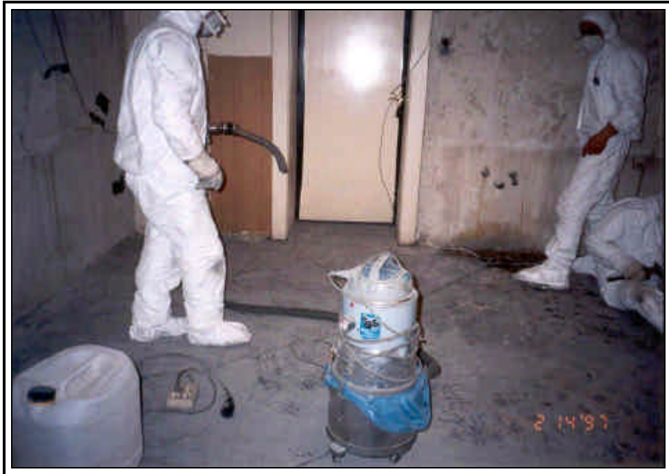
Bild 13: Grobreinigung der Sanierungszone
