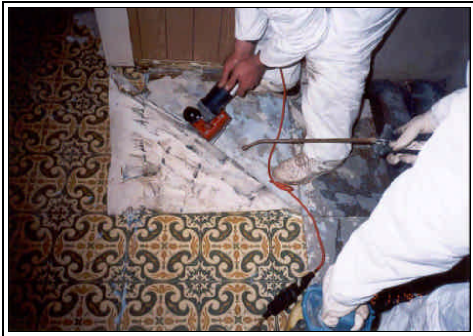
Bild 5: Abziehen der Deckschicht bei gleichzeitigem Nässen
