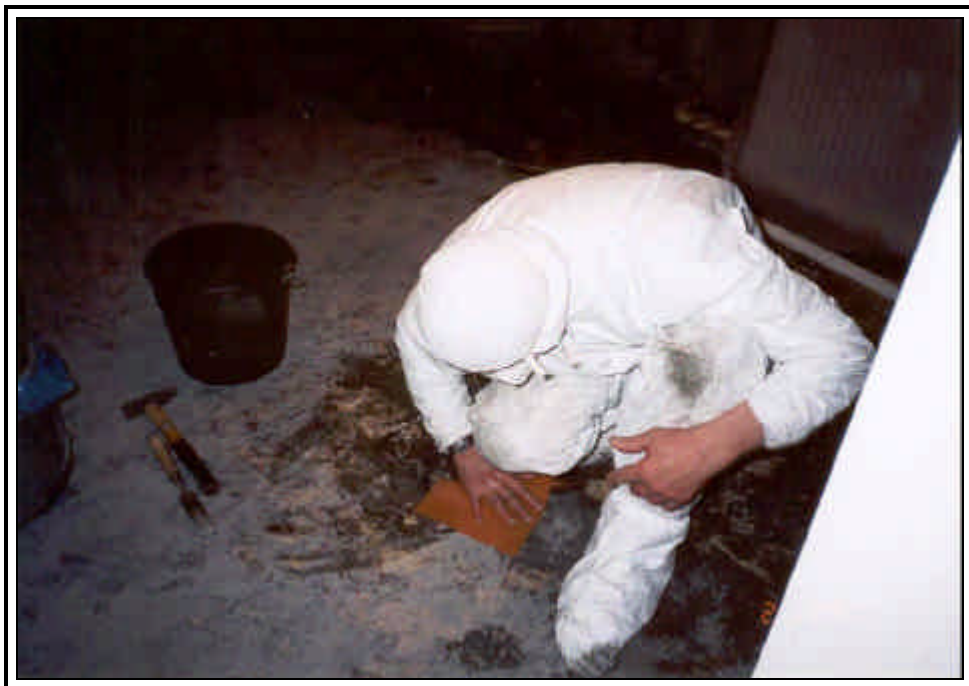
Bild 14: Feinreinigung der Sanierungszone
