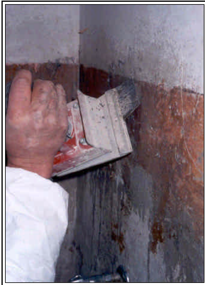
Bild 11: Entfernung der Kleberreste - Detail
