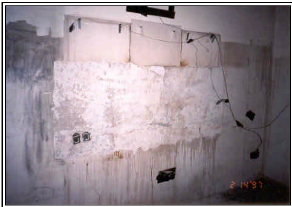
Bild 12: Wandfläche nach Belagsentfernung
