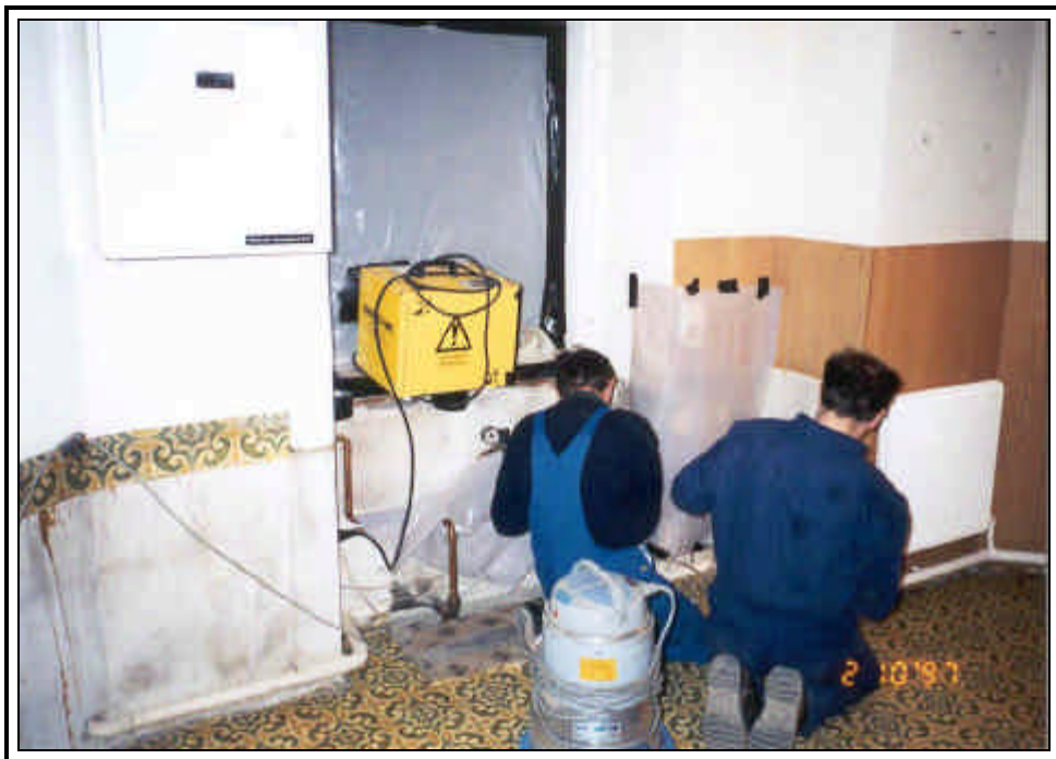
Bild 2: Einbau UHG im Fenster
