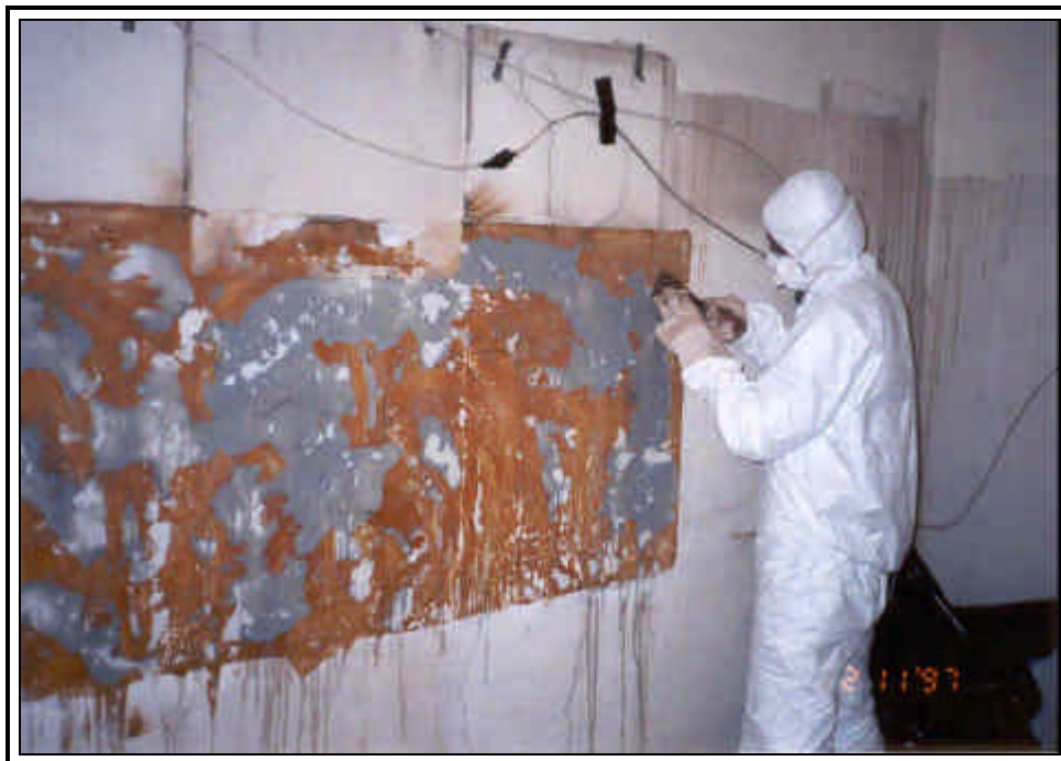
Bild 10: Entfernung der Kleberreste an der Wand
