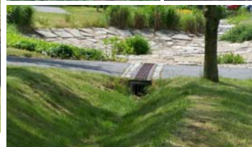
Gestaltete Retentionsflächen und Gräben zur Versickerung des Oberflächenwassers
