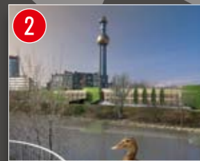
2 PARKDECK Neues Leben für die Stadt- bahnbögen
